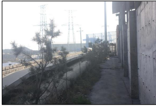
照片 30 厂区道路绿化
