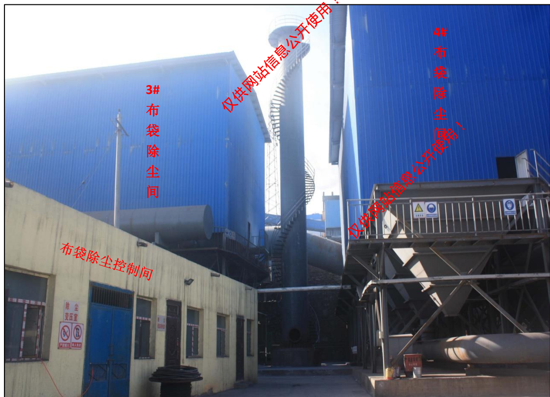
照片 4 已建 25m 高排气筒（未利用）
