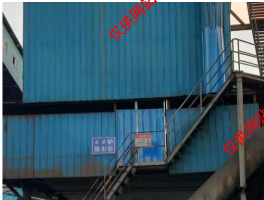
照片 27 除尘间标志
