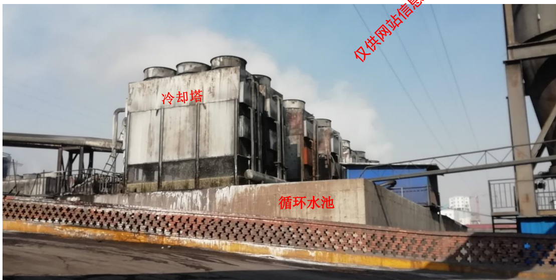
照片1 硅铁厂冷却塔及循环冷却水池（1200m 3 ）
