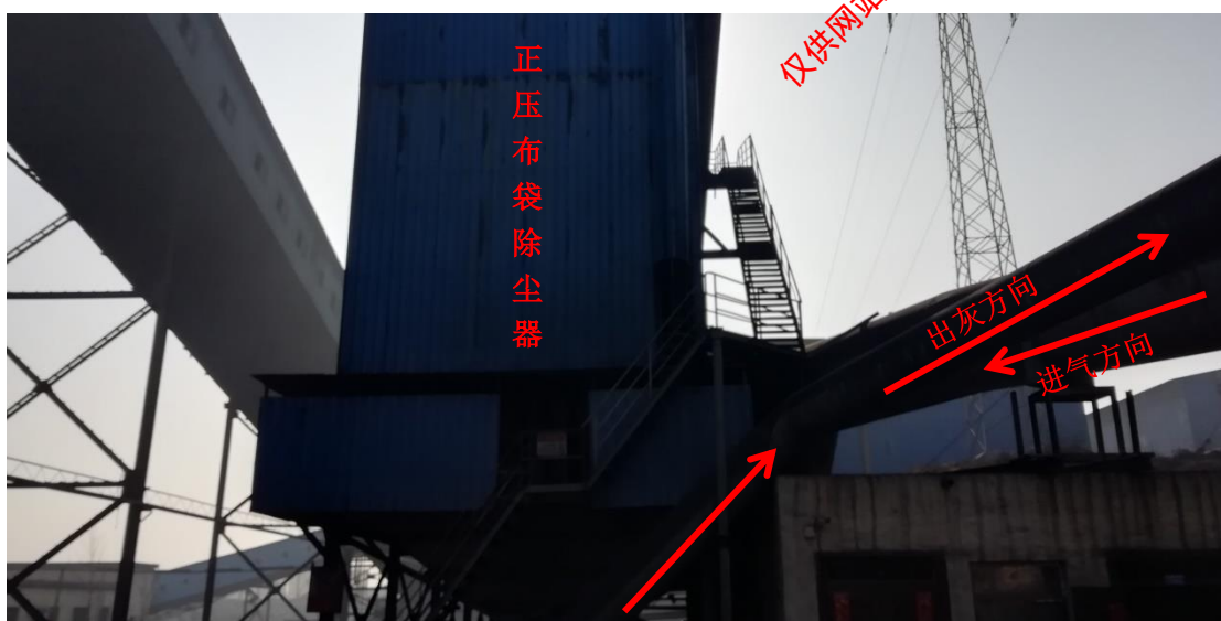
照片 7 硅铁炉废气 4#-2 布袋除尘间
